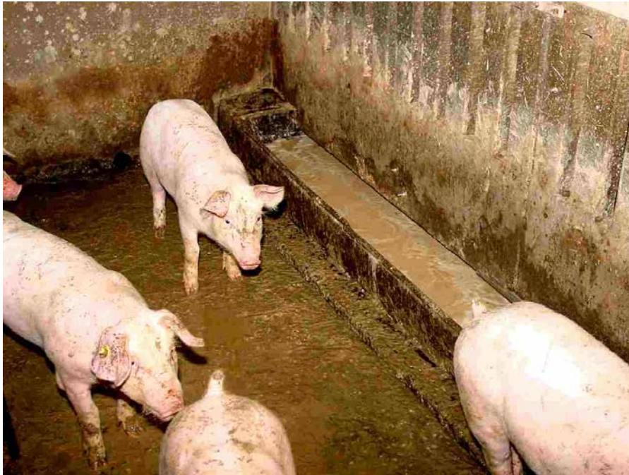
Figuur 11: Een hok dat niet goed is uitgevoerd werkt hokbevuiling in de hand, zeker als ook het voermanagement niet goed is (foto H. Hendriks)
