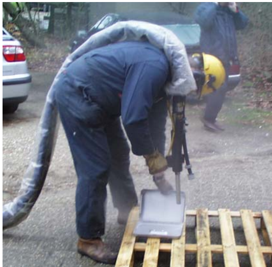
Figuur 12: Reinigen met het Ice Blast systeem
